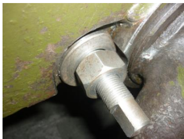
Рисунок 4 – Монтаж торсионного вала
